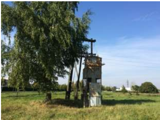
8.attēls. Skats uz esošu transformatoru apakšstaciju pie Ulbrokas ielas
